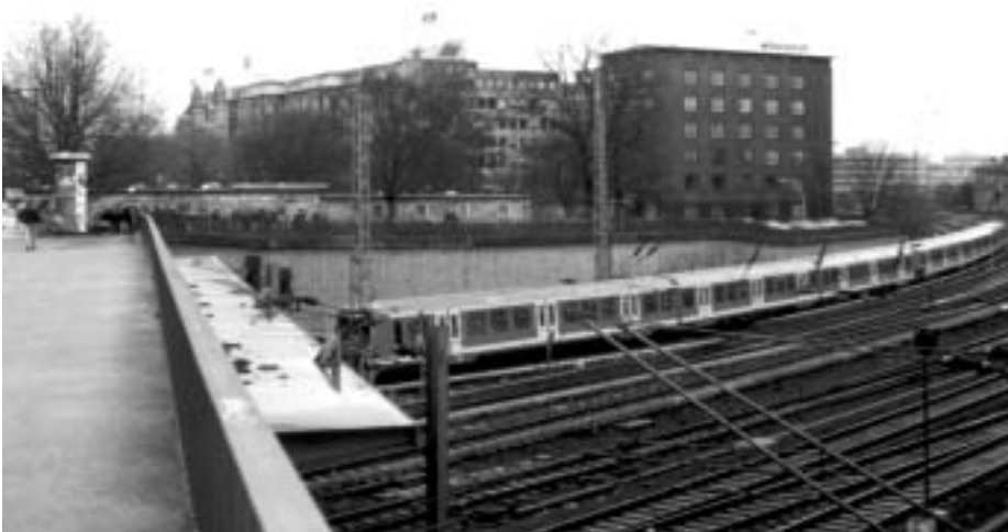
An der Kurt-Schumacher-Allee links die Container des Drob Inn, rechts daneben an der Repsoldstraße das Wüstenrot-Haus
